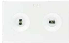
Lente pasillo (cruce techo)
