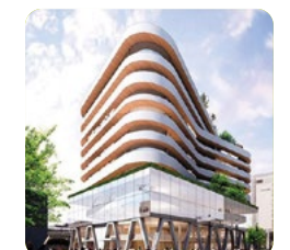
Sede centrale di De Persgroep, la più importante azienda multimediale del Belgio (Anversa)
